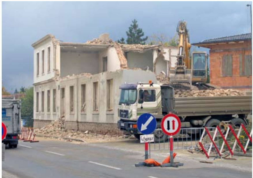
Abriss des alten Gemeindehauses Haugsdorf
